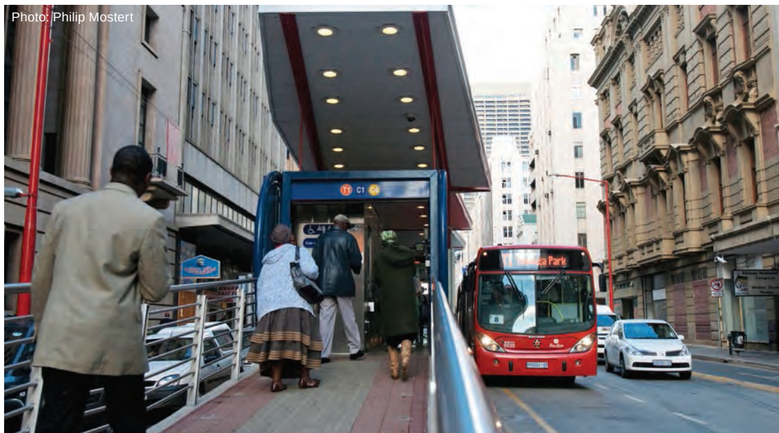
快速公交系统能将乘客直接运送到城市中心。
