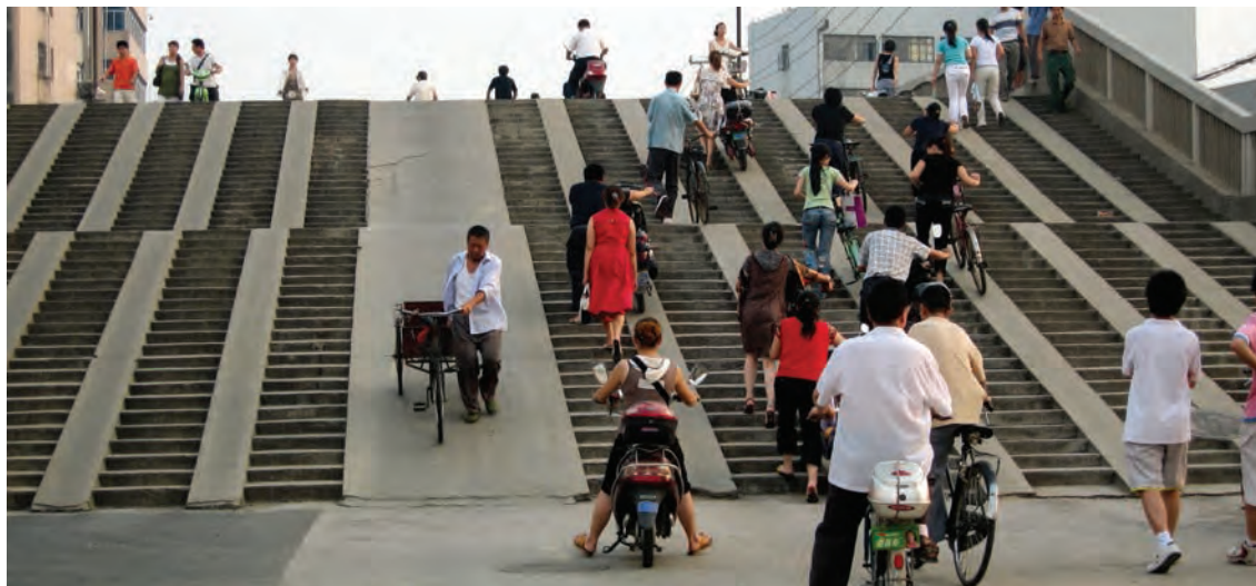
一些简单改变,如为自行车在阶梯中增设一条斜坡道,使通行更加顺畅。中国 常州
